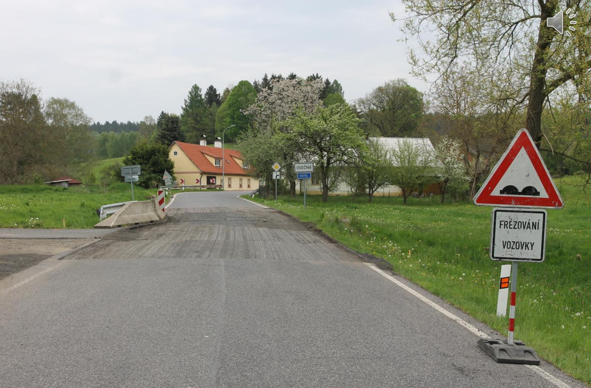
14.duben – začíná oprava poškozeného krajského propustku v Kotli...
